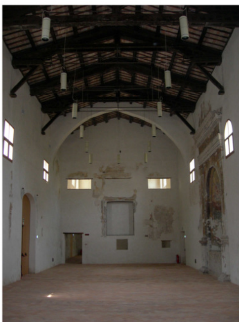
Chiesa di Santa Caterina – spazio interno
