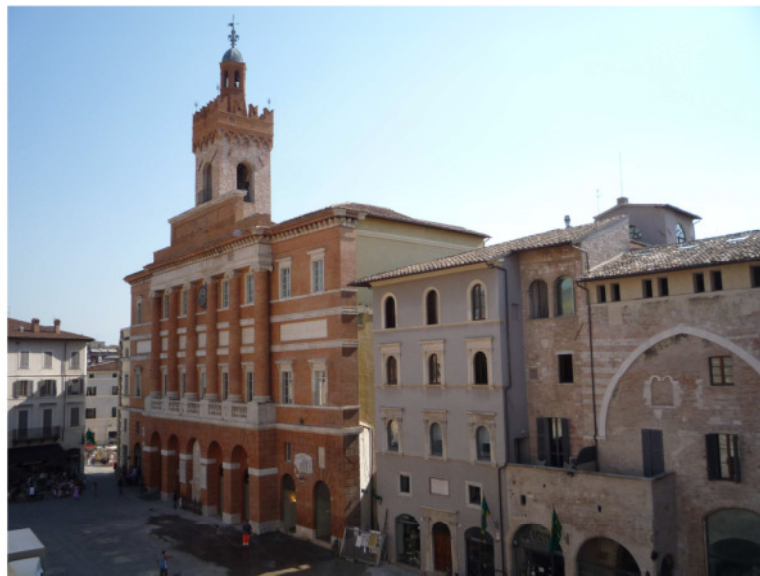
Palazzo Onofri e Torrino: facciata su piazza della Repubblica
