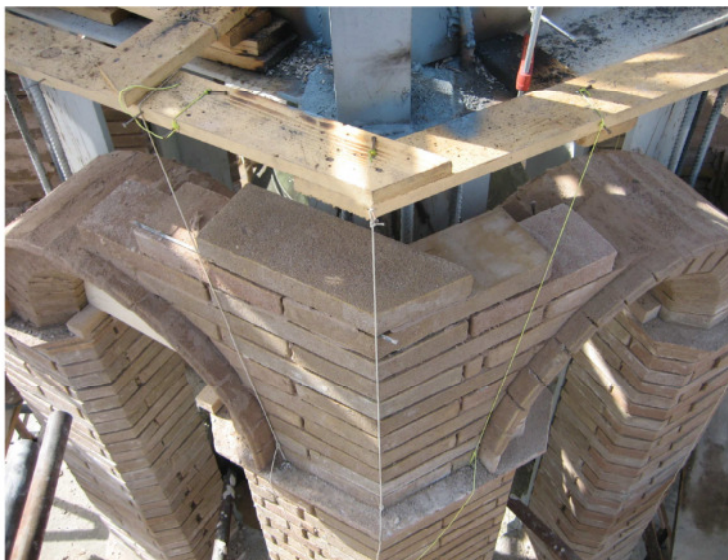
2007 – ricostruzione del torrino di palazzo comunale
