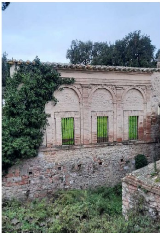
Immagine quinta muraria sul lato Sud
