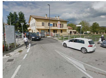
Ponte sul Topino di Largo Marchisiello
