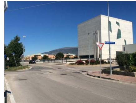
Via Giovanni Paolo II in ingresso al nodo
