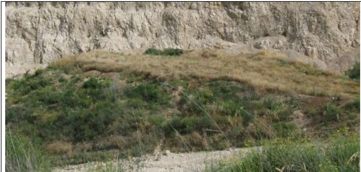
Foto 4 - Cumuli di terreno da utilizzare successivamente per i lavori di risistemazione ambientale.
