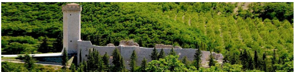
Vista esterna della Rocca, lato nord, dopo l'esecuzione di un primo stralcio dei lavori e prima della ricostruzione delle mura lato sud. E' ancora presente la vegetazione di pinus nigra.
