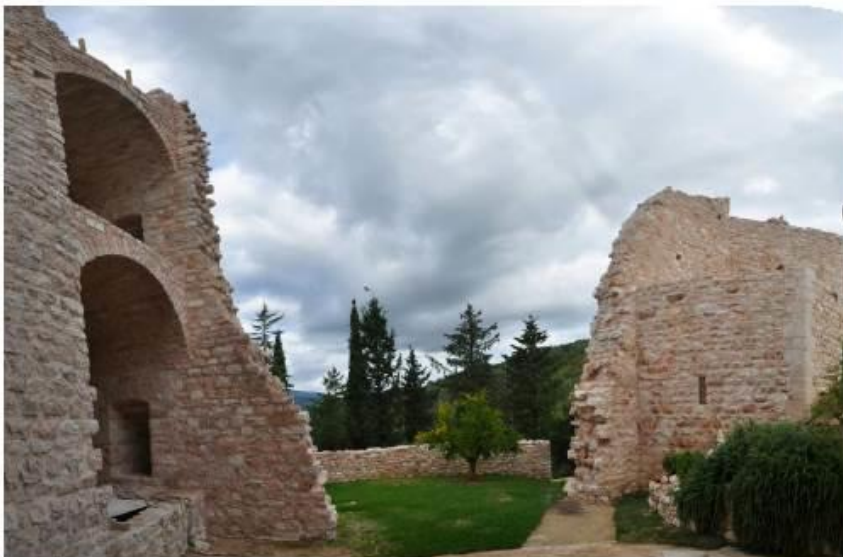
L'ingresso sud-est visto dalla corte interna
