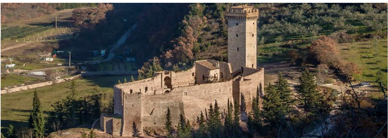
Vista aerea della Rocca dopo recenti lavori di restauro
