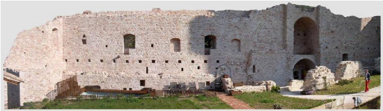
Parete nord – rilievo fotografico dello stato ATTUALE
