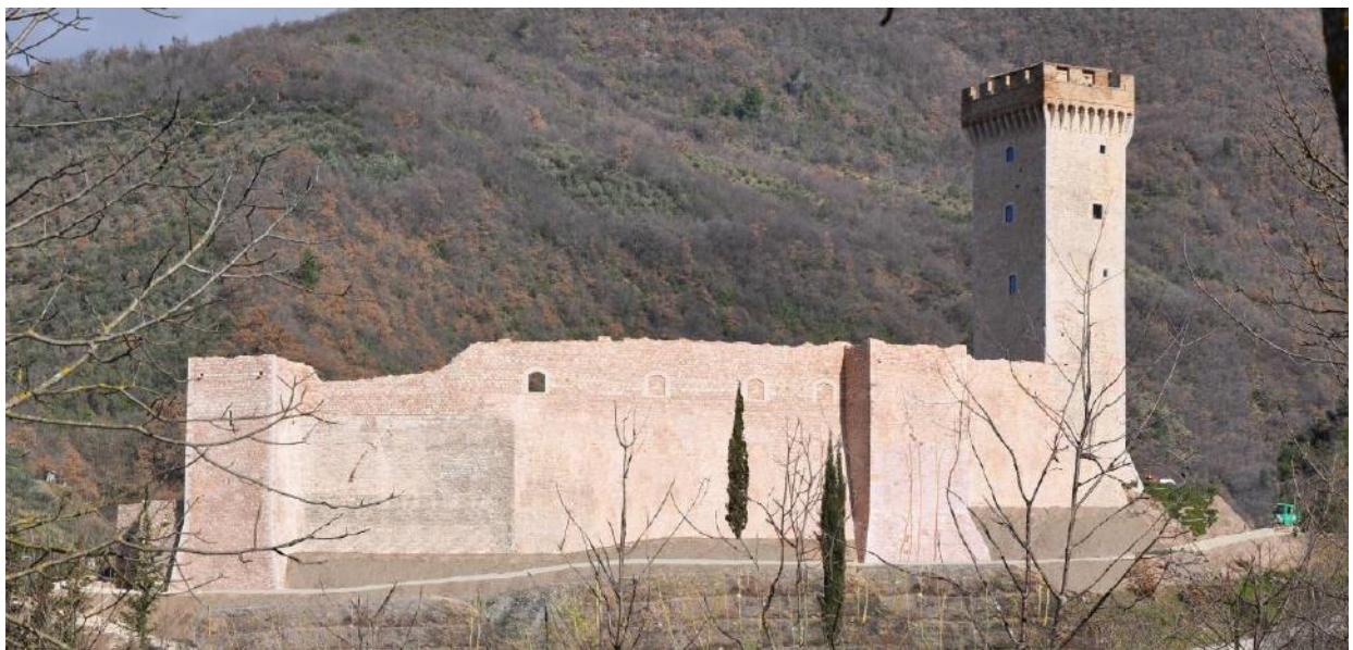
Vista esterna della Rocca dopo i lavori di ricostruzione e restauro delle mura
