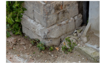
19- Basamento dello stipite costruito in epoca settecentesca con mattoni di grande spessore poi levigati per essere lasciati a faccia vista.
