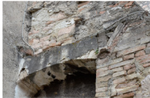
11- Particolare dei peducci di imposta della volta a mattoni di epoca quattrocentesca ai lati dell'antica finestra.
