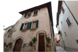
4- Rapporto dell'edificio con Via Acquavite.
