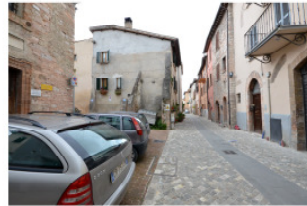
3- Contesto ravvicinato intorno alla parte diruta dell'edificio.
