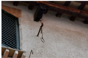
16- Particolare dell'angolo della finestra di destra.
