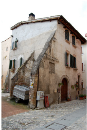
1- Parte diruta dell'edificio, oggetto di intervento.
