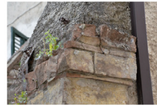
18- Capitello dello stipite costruito in epoca settecentesca con mattoni di grande spessore poi levigati per essere lasciati a faccia vista.
