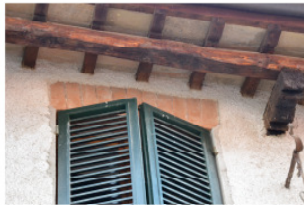
15- Finestra di destra con braccio in ferro battuto, mensola in legno modanato e gronda di epoca settecentesca, architrave in mattoni di epoca settecentesca.
