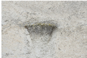
10- Particolare del peduccio di imposta della volta a mattoni di epoca quattrocentesca intonacato di recente.
