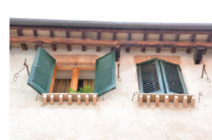
13- Resti di finestre di epoca quattrocentesca, con bracci in ferro battuto originali e con architravi di epoca settecentesca in sostituzione delle originali ghiera ad arco.
