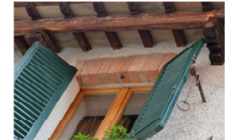
14- Finestra di sinistra con braccio in ferro battuto, mensola in legno modanato e gronda di epoca settecentesca, architrave in mattoni di epoca settecentesca.
