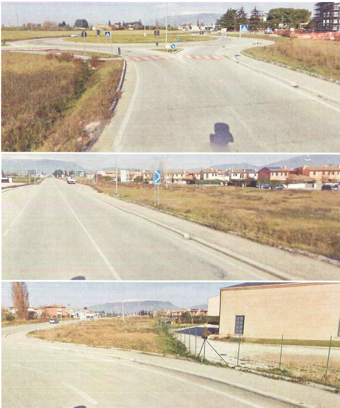
Fig. 4. Bretella di collegamento rotatorie a Ovest del PPE "Ex zona C8 in frazione Borroni" (prolungamento via D. Manin) allo stato attuale, non esistente nel 2004. Dall'alto in basso: rotatoria Nord, bretella vista da Sud, innesto rotatoria Sud (chiesa sulla dx) [da Google, 2011].
