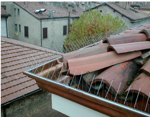
Fig. 1 Sistema di dissuasione a spilli utilizzabile per cornicioni, davanzali, lampioni, marcapiani, lesene
