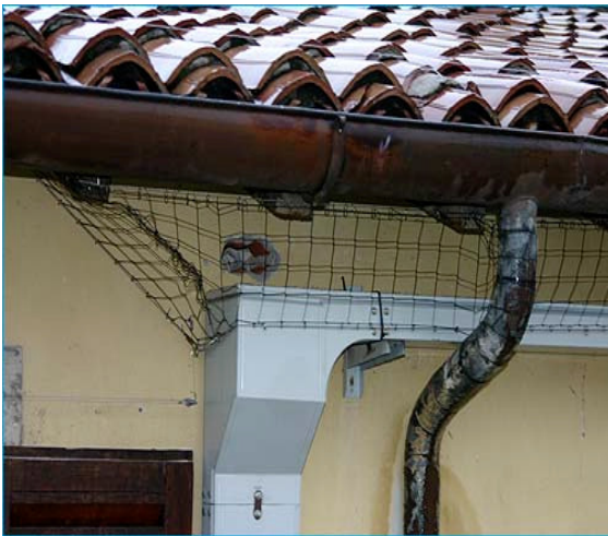
Fig.3 Sistema di dissuasione a rete utilizzabile per abbaini aperti o ciechi
