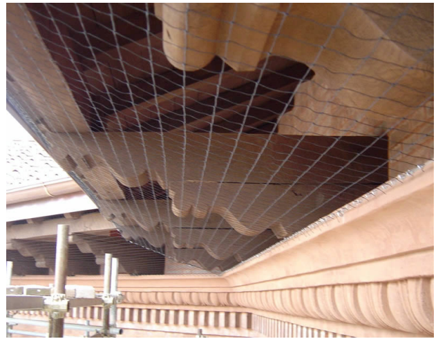
Fig.3 Sistema di dissuasione a rete utilizzabile per abbaini aperti o ciechi
