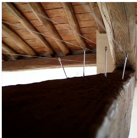
Fig. 2 Sistema di dissuasione a filo ballerino utilizzabile per davanzali, tetti, sottotetti, ecc...
