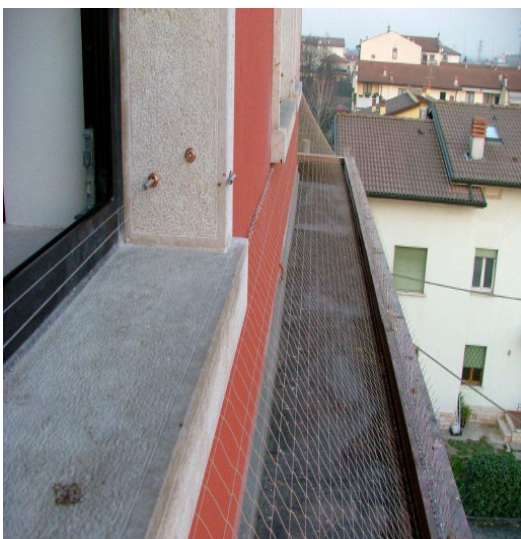
Fig. 2 Sistema di dissuasione a filo ballerino utilizzabile per davanzali, tetti, sottotetti, ecc...
