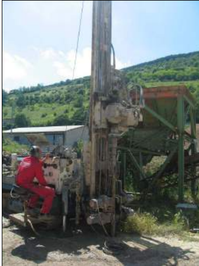
FOTO N°1: PIAZZOLA DEL SONDAGGIO N°1
