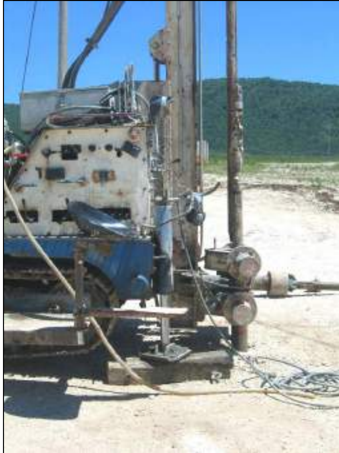
FOTO N°7: PIAZZOLA DEL SONDAGGIO N°2
