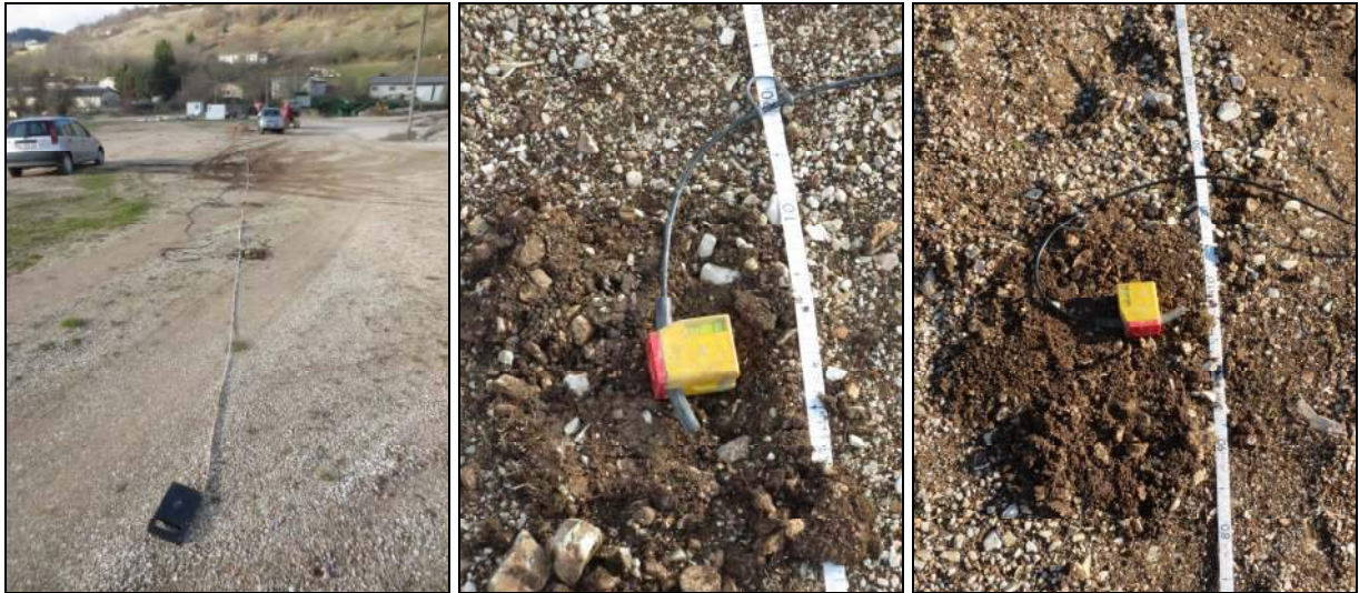
FOTO N°4: UBICAZIONE STENDIMENTI PROFILI SISMICI IN ONDE S E MASW E PARTICOLARI GEOFONI INSTALLATI
