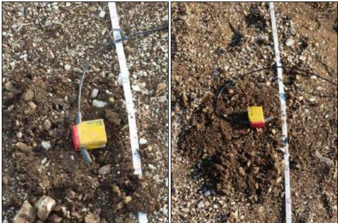
FOTO N°18: PARTICOLARE GEOFONI INSTALLATI PER PROFILO SISMICO IN ONDE "S" E "MASW"
