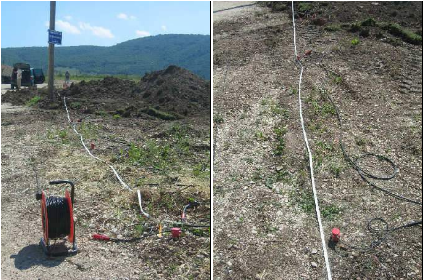
FOTO N°13: STENDIMENTO DEL PROFILO SISMICO IN ONDE "P" E PARTICOLARE (GEOFONI INSTALLATI)
